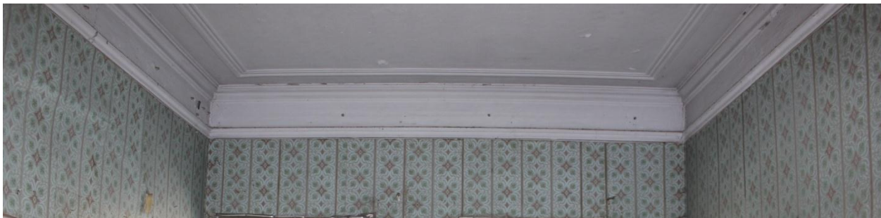
Штукатурный карниз второго этажа, фото 2018г
